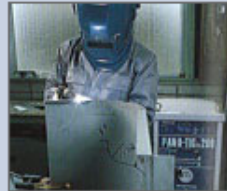
アルゴン溶接
