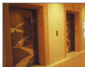
浅草ビューホテル エレベーター出入口枠及扉
